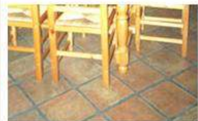
Piso de Baldosa
