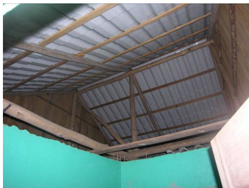
Techo del ranchito, sin finalizar
