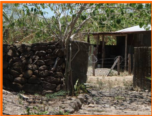
Muro de piedra reparado
