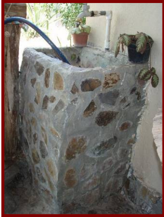
Pila construida con piedras sacadas de la zona
