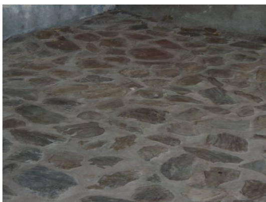
Piso del corredor elaborado utilizando como base piedra. Elemento presente de manera muy frecuente en la Región.
