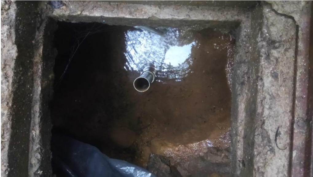
Figura 3: Vista interna del tanque de captación.
