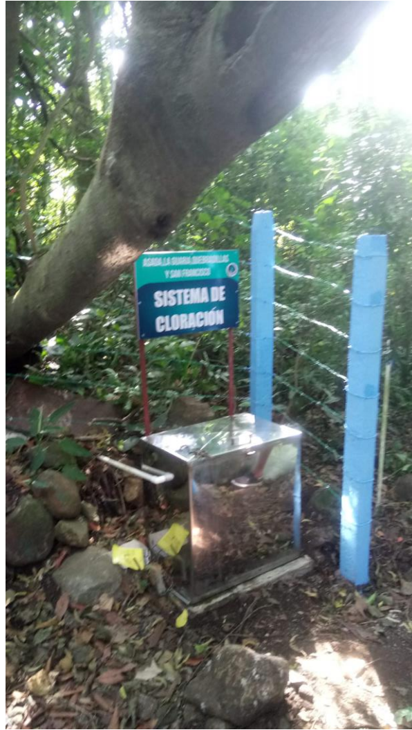
Figura 3: Sistema de cloración con pastilla, junto al manantial.
