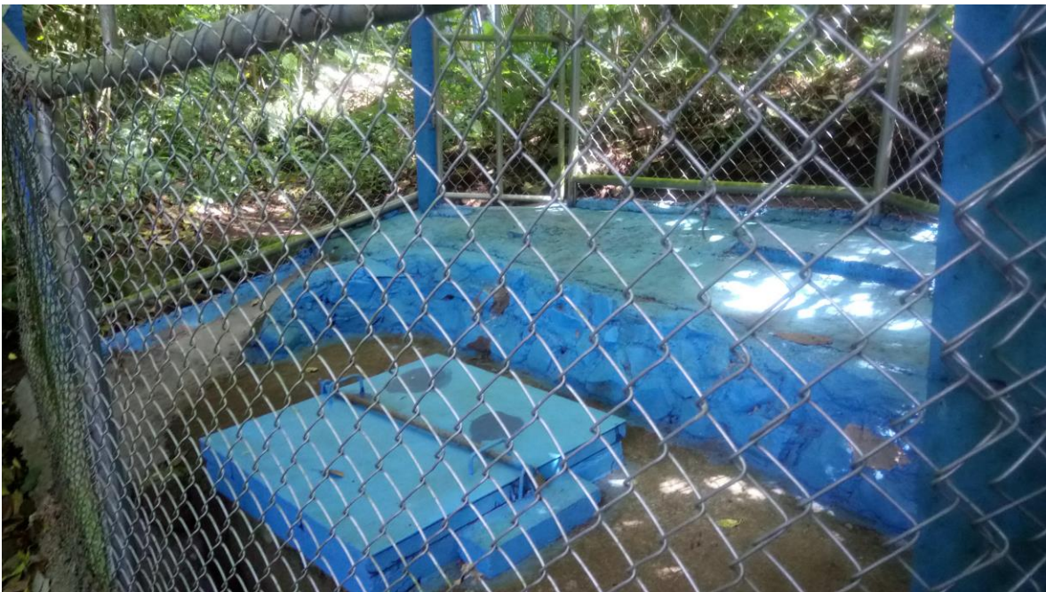
Figura 2: Captación de Manantiales de Piedades Sur.
